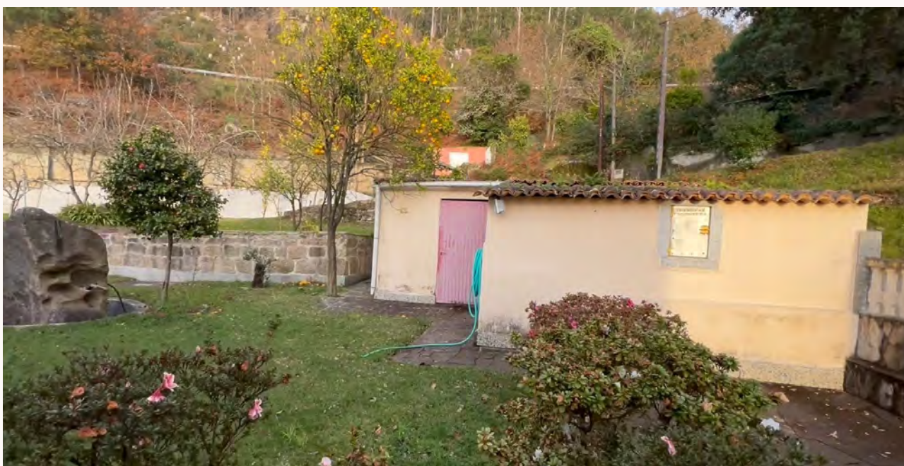
Almacén exterior a la cota de planta alta.
